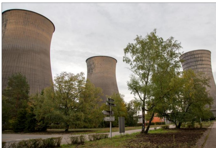
La fermeture de la centrale à charbon Émile-Huchet à Saint-Avold est prévue à court terme en 2022. Photo RL
